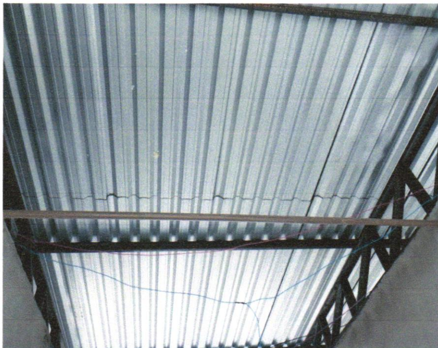
FOTO 05 – TELHAMENTO COM TELHA METÁLICA TERMOACÚSTICA E = 30 MM, COM ATÉ 2 ÁGUAS, INCLUSO IÇAMENTO. AF_07/2019
