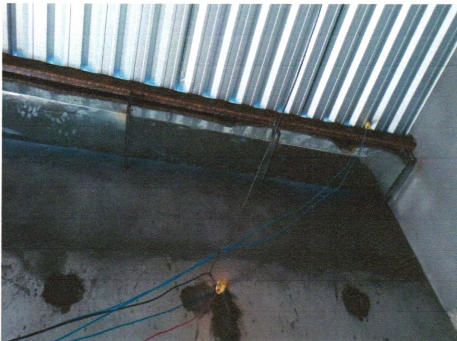
Foto 13 - -CABO DE COBRE FLEXÍVEL ISOLADO, 2,5 MM 2 , ANTICHAMA 450/750 PARA CIRCUITOS TERMINAIS - FORNECIMENTO E INSTALAÇÃO. AF_12/2015
