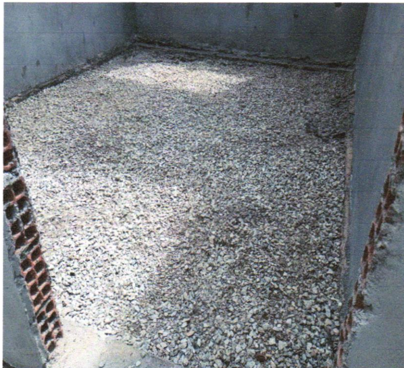
Foto 18 - Lastro de brita graduada apiloada e=10cm
