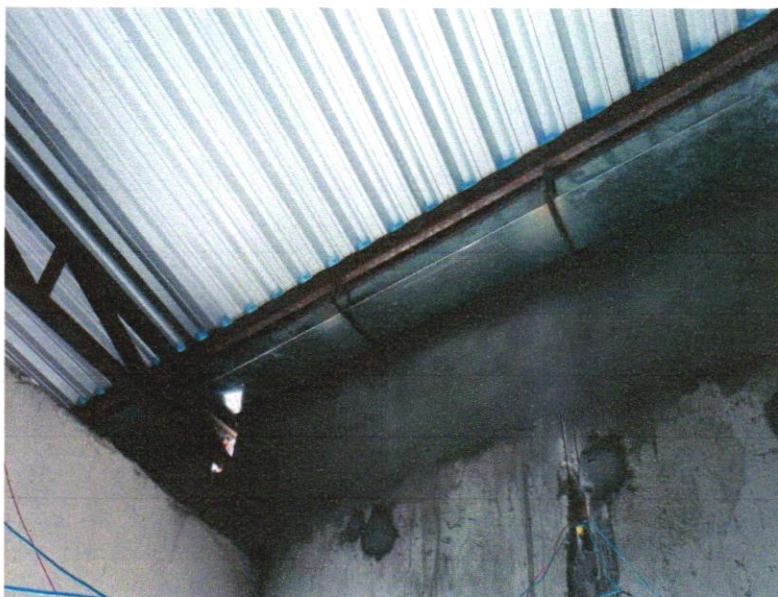
FOTO 08 – CALHA EM CHAPA DE AÇO GALVANIZADO NÚMERO 24, DESENVOLVIMENTO DE 100 CM, INCLUSO TRANSPORTE VERTICAL. AF_07/2019
