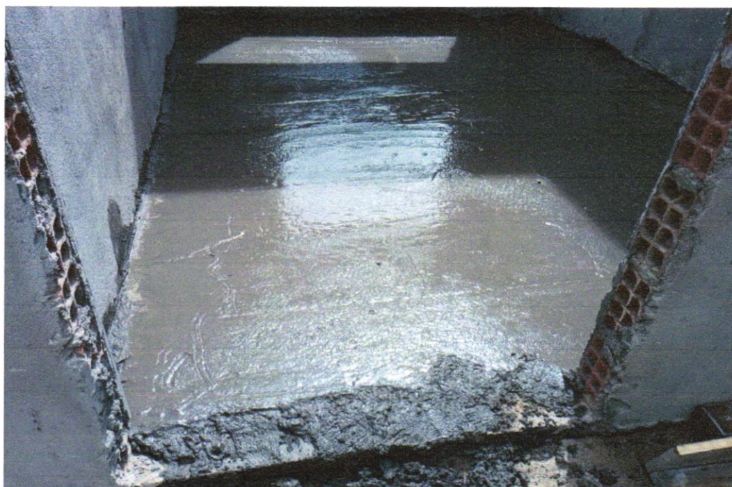
Foto 19 - APLICAÇÃO DE LONA PLÁSTICA PARA EXECUÇÃO DE PAVIMENTOS DE CONCRETO. AF_04/2022
