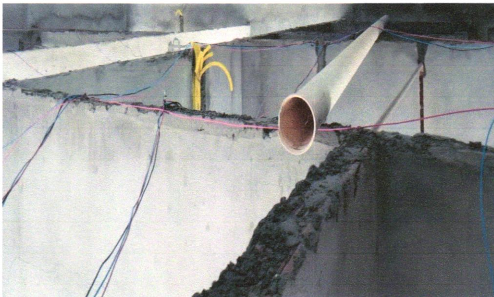
Foto 11 - CABO DE COBRE FLEXÍVEL ISOLADO, 4 MM 2 , ANTI-CHAMA 0,6/1,0 KV, PARA CIRCUITOS TERMINAIS - FORNECIMENTO E INSTALAÇÃO. AF_12/2015
