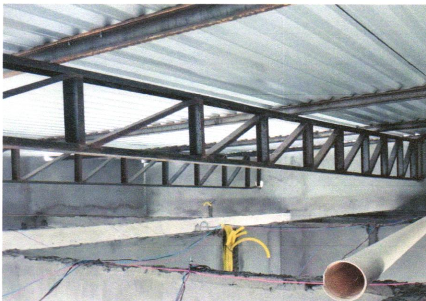
Foto 10 - FABRICAÇÃO E INSTALAÇÃO DE TESOURA INTEIRA EM AÇO, VÃO DE 10 M, PARA TELHA ONDULADA DE FIBROCIMENTO, METÁLICA, PLÁSTICA OU TERMOACÚSTICA, INCLUSO IÇAMENTO AF_12/2015
