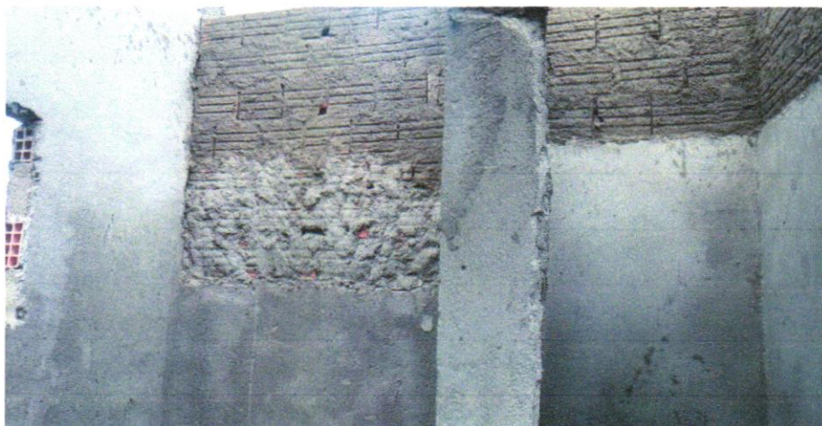
FOTO 02 – CHAPISCO APLICADO EM ALVENARIAS E ESTRUTURAS DE CONCRETO INTERNAS, COM COLHER DE PEDREIRO. ARGAMASSA TRAÇO 1:3 COM PREPARO EM BETONEIRA 400L.
